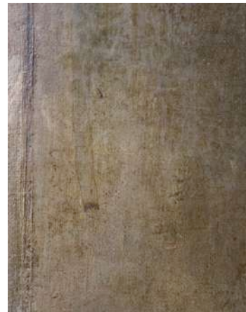
Détail de l'encrassement et des coulées grises présentes sous le vernis
