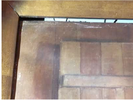
Coin supérieur gauche – jour entre le cadre et le tableau. Encrassement et griffes superficielles
